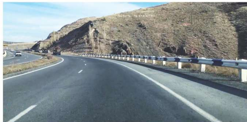
Барьерные ограждения на дороге «Ереван – Севан»
