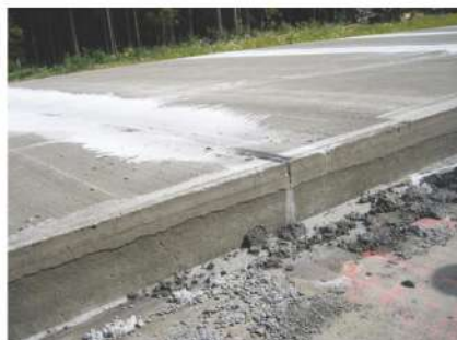
Рисунок 6. Укладка двухслойных покрытий машинами фирмы Wirtgen А – комплект машин для укладки двухслойного бетонного покрытия Б – двухслойное бетонное покрытие
