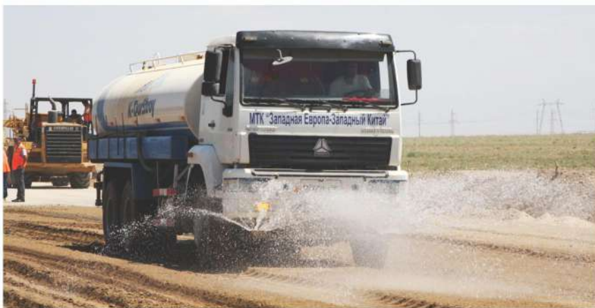
Рисунок 3. Внесение водного раствора химического стабилизатора «Полидор» в шлакоминеральную бетонную смесь
