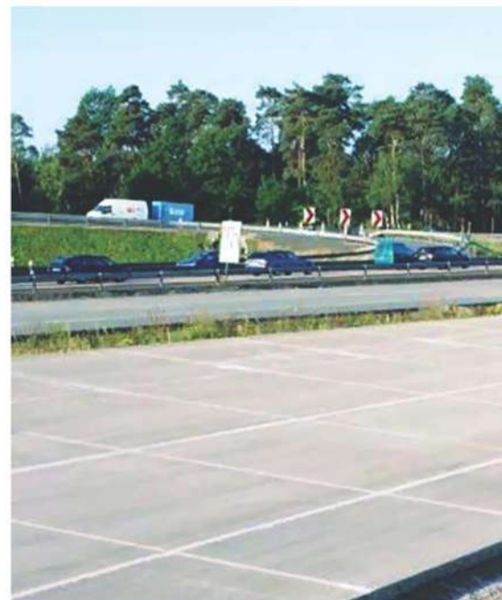
Рисунок 5. Покрытие цементобетонной дороги
