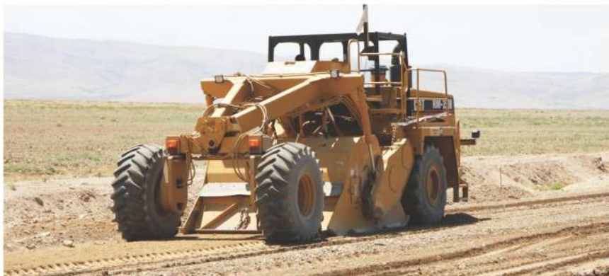
Рисунок 4. Перемешивание шлакоминеральной смеси после внесения водного раствора Полидор грунтосмесителем
