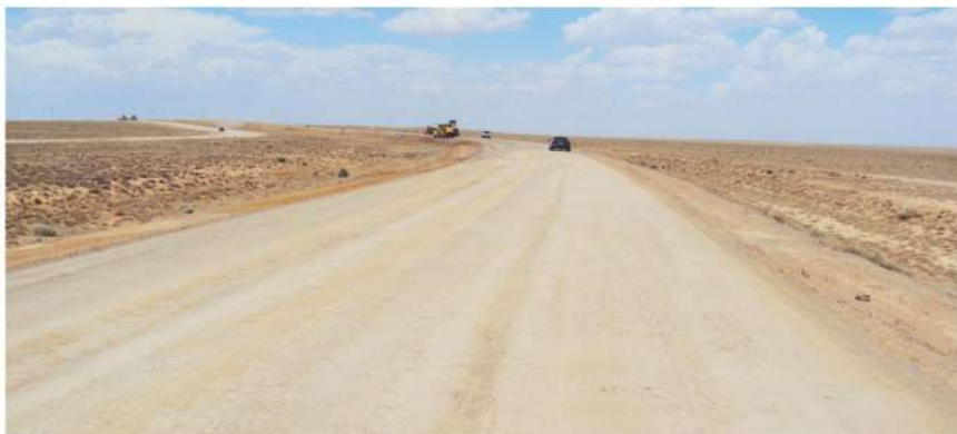
Рисунок 5. Общий вид уплотненного шлакоминерального бетонного основания
