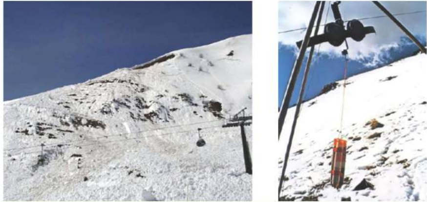
Рис. 2. Пример тросовой доставки взрывных устройств в горной местности
