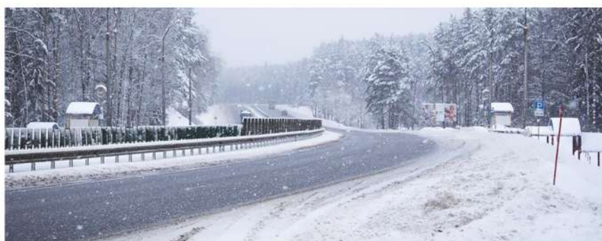
Рис. 5. Примеры защитных сооружений от заносов
