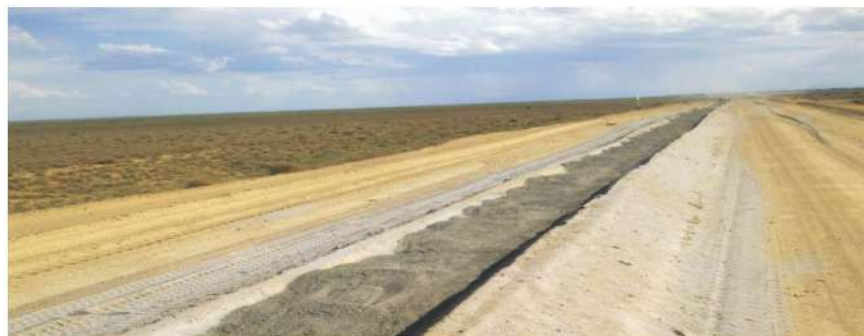
Рисунок 2. Валик шлакоминерального материала основания перед его профилированием и фрезерованием
