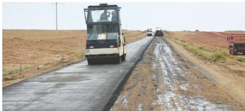
Рисунок 6. Уплотнение уложенного слоя асфальтобетонного покрытия сверх монолитного шлакоминерального бетонного основания автомобильной дороги «Шиели-Тойконур»
