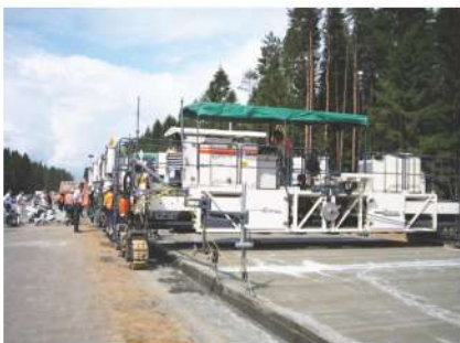
Рисунок 6. Укладка двухслойных покрытий машинами фирмы Wirtgen А – комплект машин для укладки двухслойного бетонного покрытия Б – двухслойное бетонное покрытие
