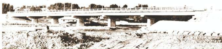
Мост через реку Гусарчай (1959 г., дл.146,6 м)
