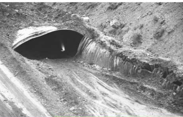
Рис. 2. Раздавленная лавиной противолавинная галерея из гофрированной стали. 2002 г. [1]
