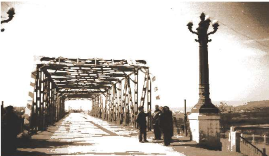
Сальянский мост через реку Кура на автомобильной дороге Баку-Астара восстановлен вместо старого наплавного моста (1946 г.)
