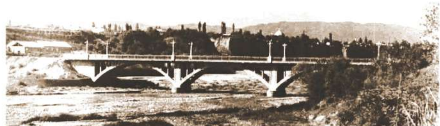
Бетонно-арочный мост на автомобильной дороге Баку-Губа гр. России через реку Кудиялчай (1956 г.)
