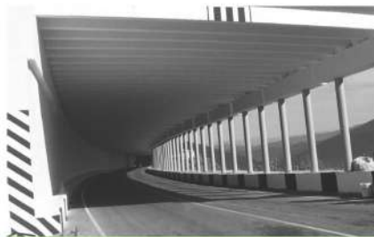
Рис. 3-4. Проливовалвинная галерея на трассе Р257 «Енисей» [4]
