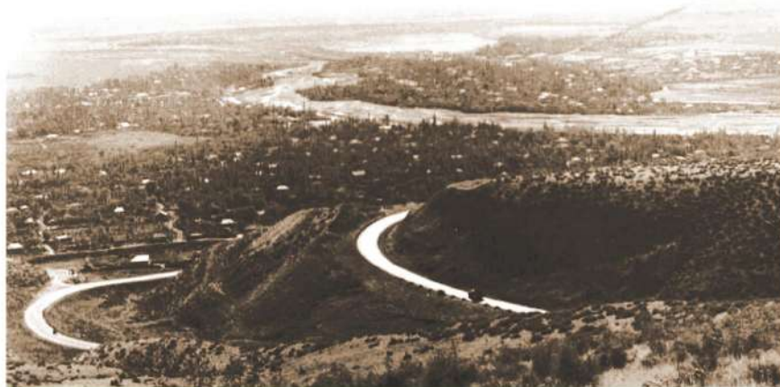
Ахсуинский перевал на автомобильной дороге Баку-Газах (серпантины)
