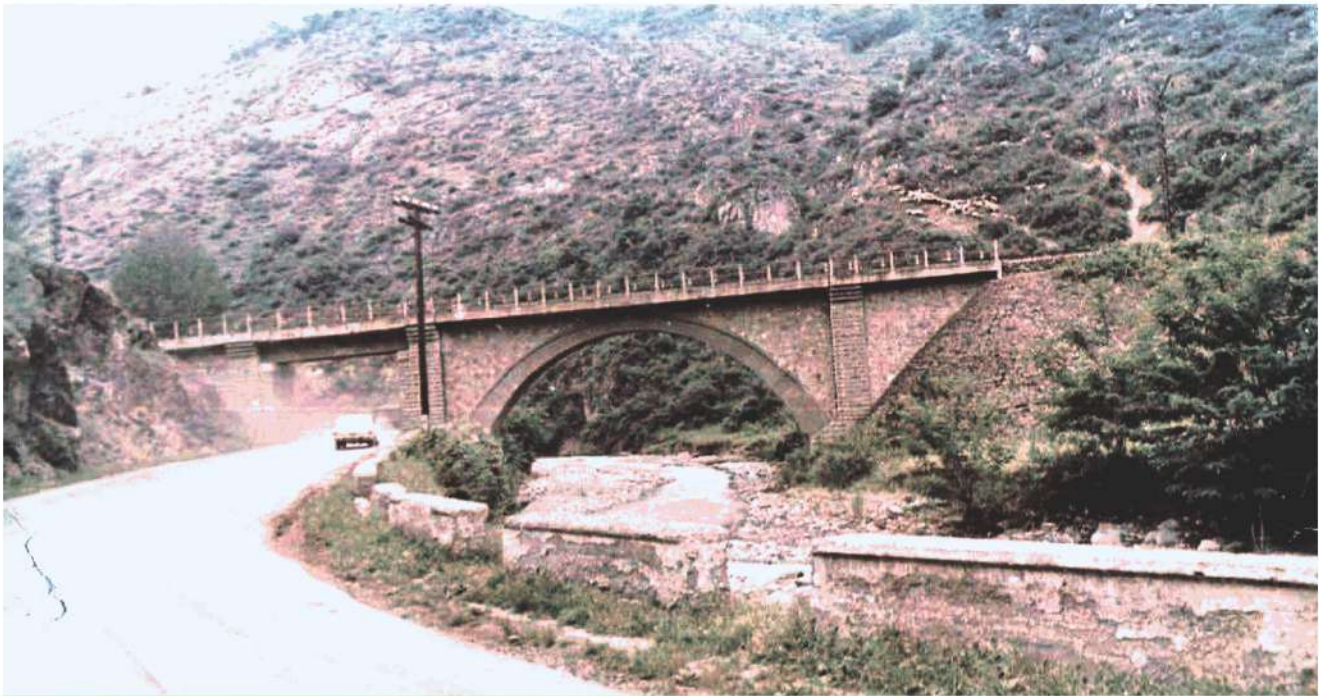
Пересечение на 20-м километре автомобильной дороги Гянджа-Дашкесан (1956 г.)
