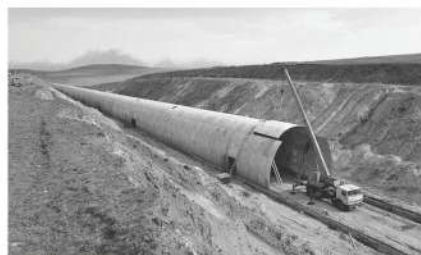
Рис. 5-6. Процесс строительства снегозащитной галереи на участке Цалка-Ахалкалаки [5]
