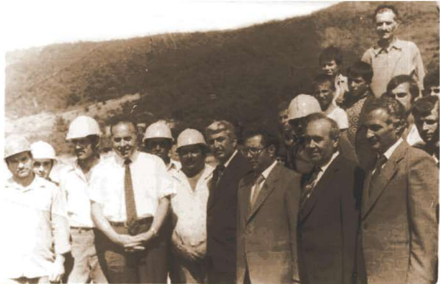
Посещение строительства автомобильной дороги Шамаха-Муганлы-Исмаиллы Первым Секретарем ЦК КП Азербайджана Г.А.Алиевым (1979 г.)
