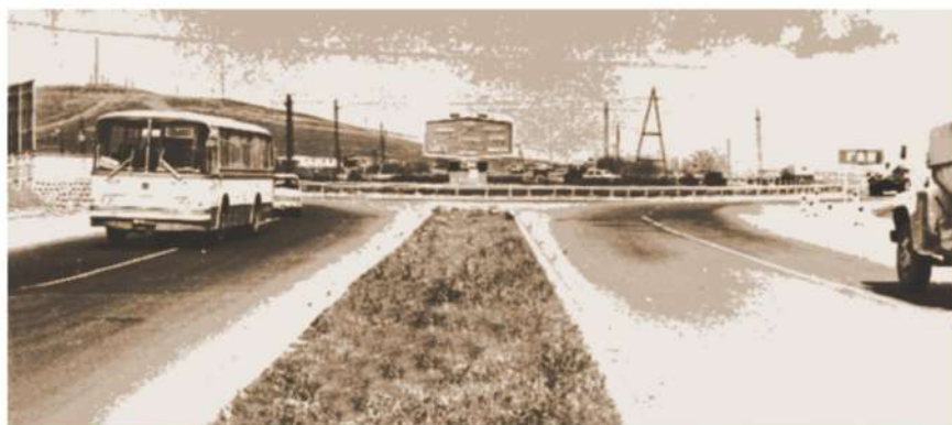
Транспортная развязка на автомобильной дороге Баку-Губа (Северный въезд к г. Баку)
