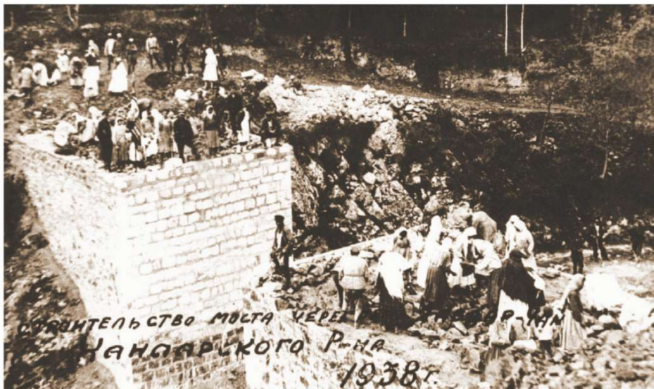
Строительство моста через реку Чавдарчай в Ханларском районе 1938 г.
