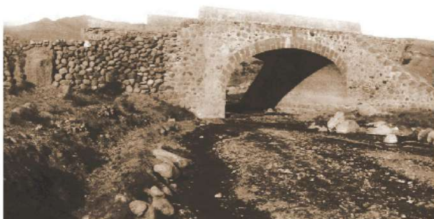
Каменно-арочный мост на дороге Хызы-Алтыагач в XIII веке, действующий после восстановления и сегодня
