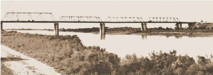
Металлический мост через реку Кура в Евлахе (1895 г., 223,67 м)
