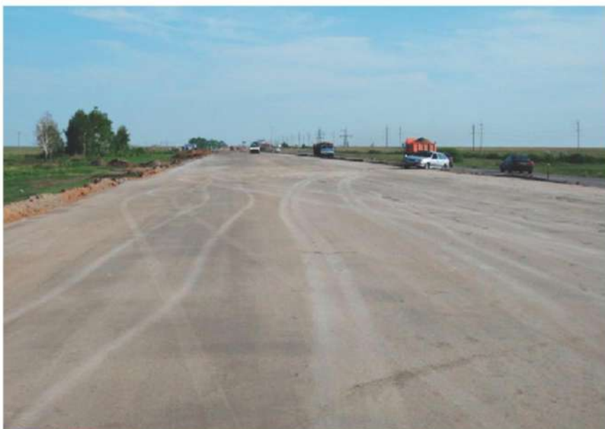
Рисунок 2. (Фото 2007г.) Готовое основание из укатываемого золотобетона на а/д «Астана – Щучинск» км 07-км57, подрядчик «К-Дорстрой», научно-методическое сопровождение ТОО КазНИПИ «Дортранс».
