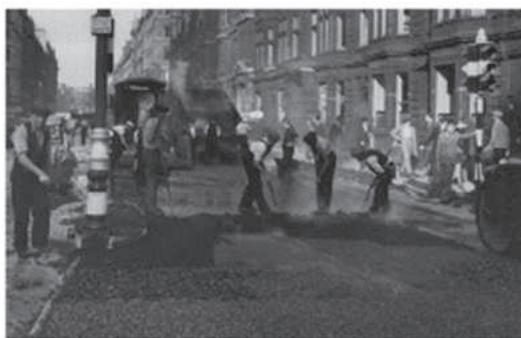
Рис. 2. Укладка первого асфальтобетона в Ньюарке, США
