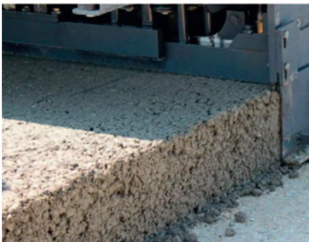
Рис. 6. Химическая стабилизация дорожных одежд
