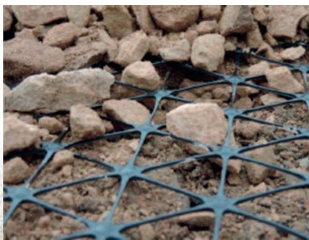
Рис. 7. Механическая стабилизация дорожных одежд
